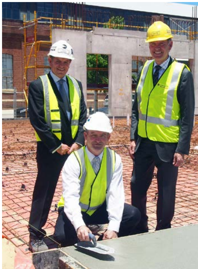
First concrete pour December 2012.
